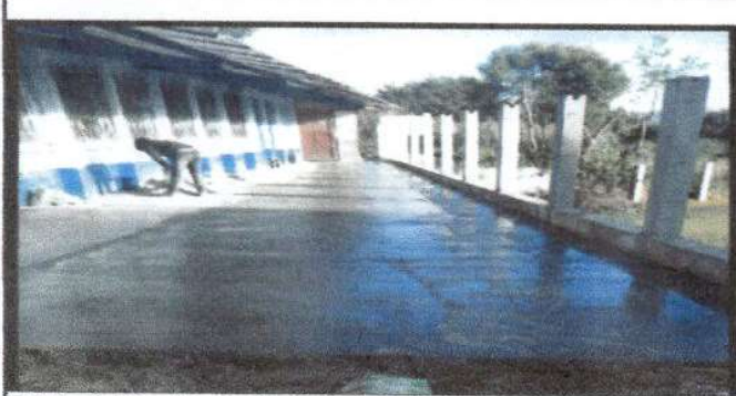
Foto1: Culminación de piso de torta de Concreto frente a la cocina y Comedor.
