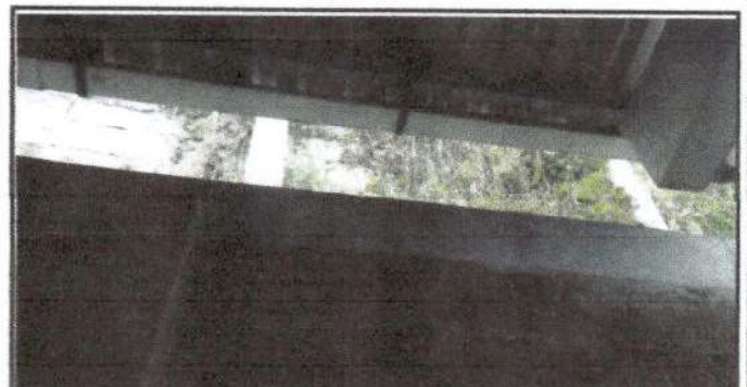
Foto 4: Finalización del Canal de Concreto sobre muro de Contención para evitar caída de agua frente a las Aulas de la Escuela.
